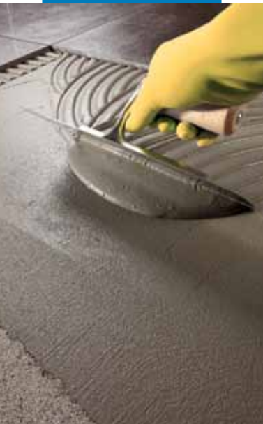
Aplicarea adezivului Kerabond T-R pe pardoseală
